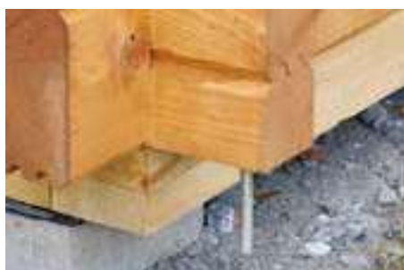
Gewindestangen ab Wandstärke 44 mm
