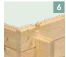
6 Eckversatz bei 40 mm Bohlen
