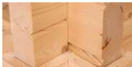
Eckverbindung 70-mm-Bohle
