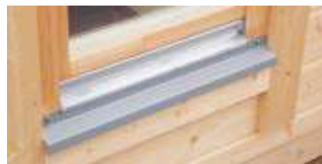
Fenster mit Metall-Fensterbank
