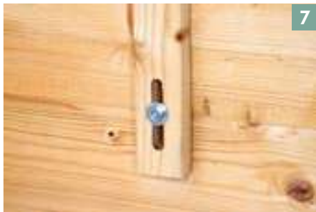
Sturmleisten sichern das Dach
