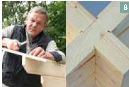
Optimale Auflage der Dachbretter
