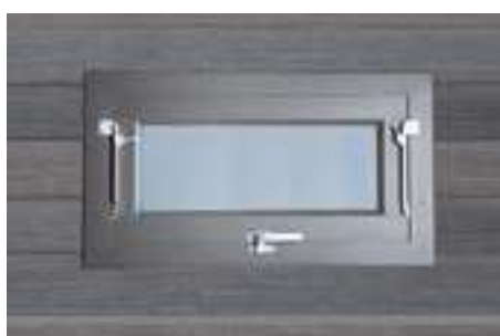
Ausstellfenster von innen, kein nachträglicher Einbau
