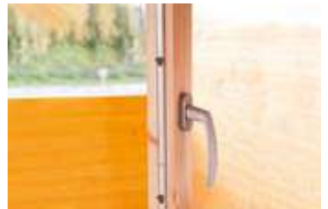
Dreh-/Kipp-Fenster mit 3-fach Verriegelung
