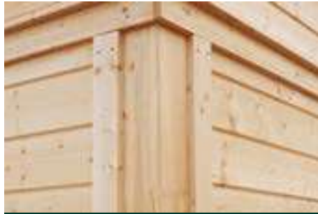
Umlaufende Leimholzkonstruktion
