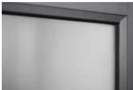
Struktur-Sicherheitsglas in Gummidichtung eingefasst
